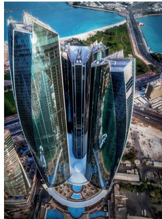
Le Etihad Towers ad Abu Dhabi dove il Gruppo Boldrin ha realizzato moduli di gestione del consumo del gas e gli impianti di intercettazione e rilevazione fughe di gas
